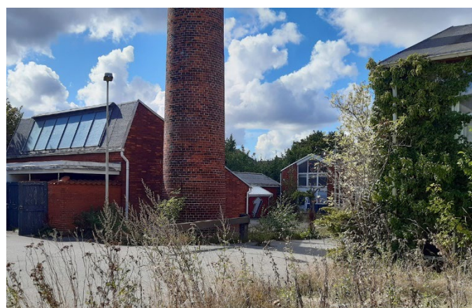
Kedelbygning med sin asymmetriske tagform og skorsten på ca. 20 m. Bygningen er en af de fire udpegede bevaringsværdige bygninger og er placeret i den sydlige del af grunden.
