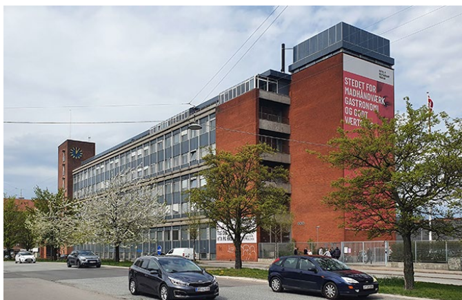
Randbebyggelsen langs Vigerslev Allé med sin markante hjørnemærkning med bl.a. ur. Billedet er taget fra sydøst midt på Vigerslev Allé.
