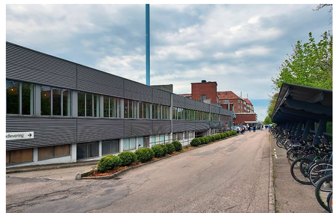
Lav bebyggelse internt på ejendommen med facade ud mod jernbanen i forlængelse af Lyshøjgårdsvej. Billedet er taget fra nordøst.
