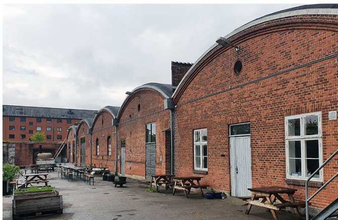
Østvendte gavlfacader - de fem sammenstillede gavle vender ud mod dels gårdmiljø afgrænset af teglmur og dels Hotel- og Restaurantskolens urtehave.
