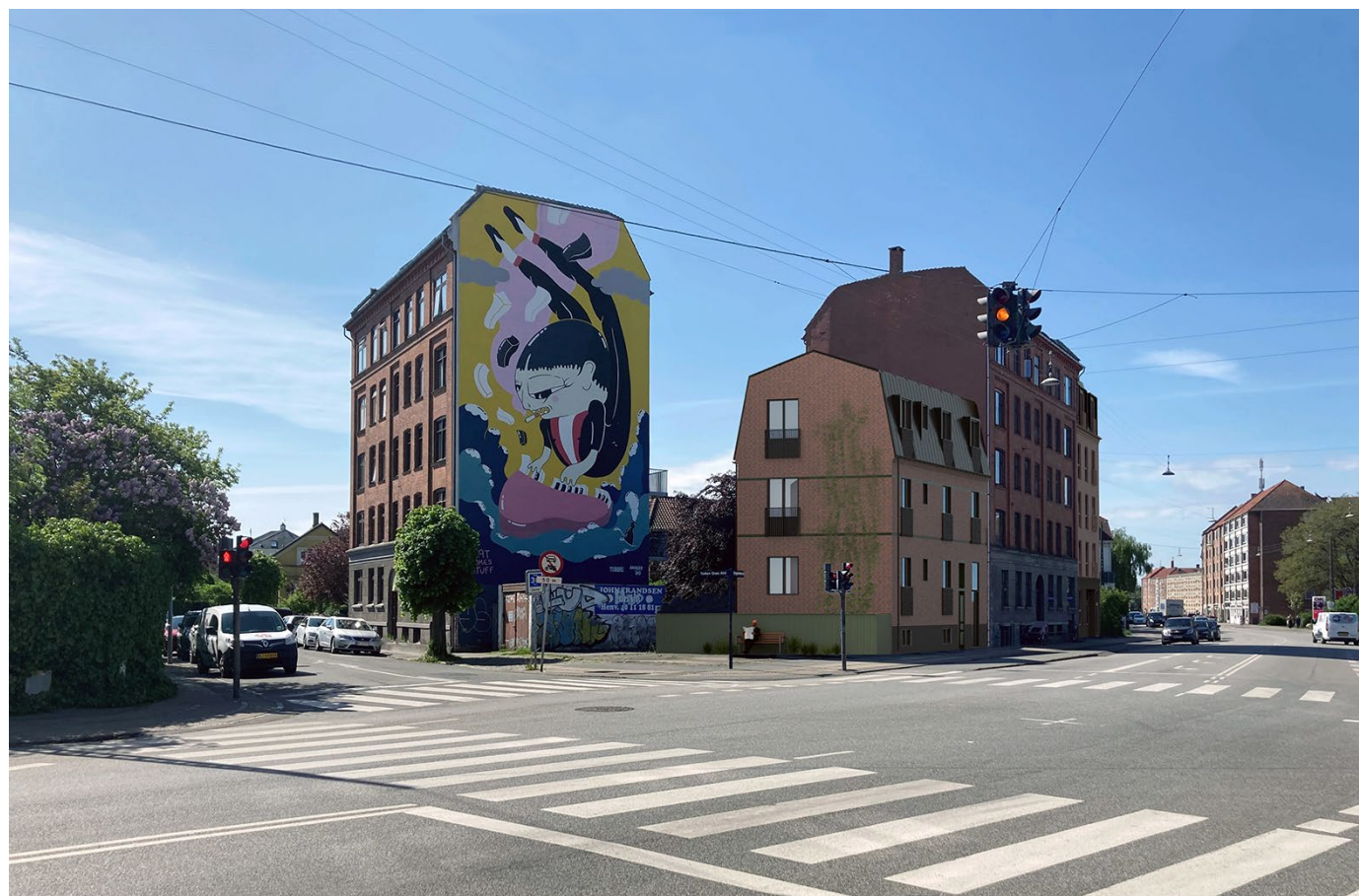
Visualisering, der viser et eksempel på et nybyggeri i overensstemmelse med lokalplanen. Engelsdvej 21, set fra krydset Engelsdvej i kontekst til Torben Oxes Allé 2 og Engelsdvej 23 og 25. Illustration: Over Byen Arkitekter.
